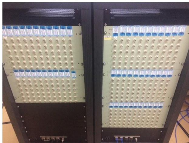
Figura 2 – Verificação dos conectores BNCs .
